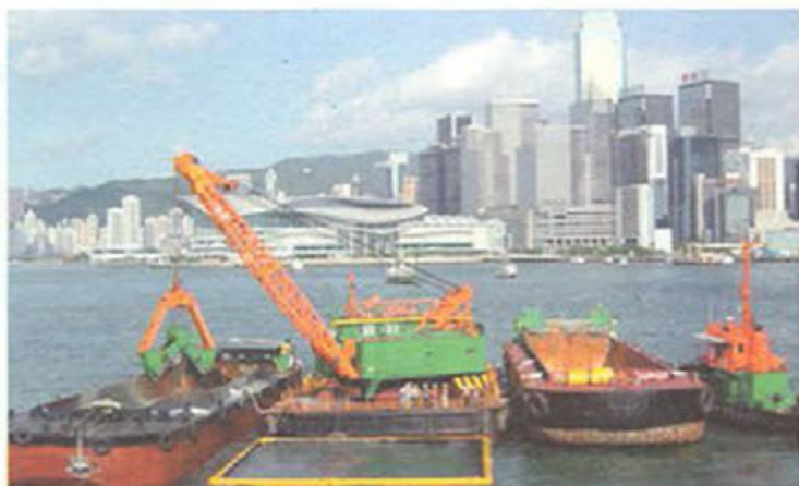
進行中的挖泥工程不會對環境造成影響 Dredging with environmental mitigation measures in place
